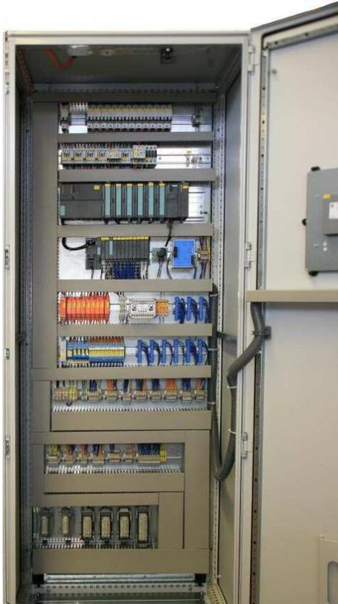
Abbildung 36: Schaltschrank Innenansicht mit Steckkupplungen IMCS-T1
