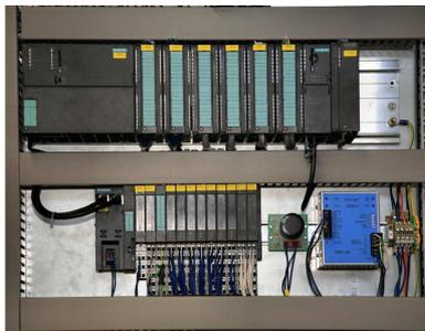
Abbildung 1: Siemens SPS mit E/A-Modulen
